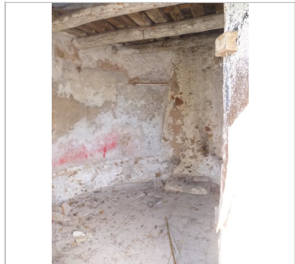
Interior. Paret nord. Traça de la llar de foc AHS
