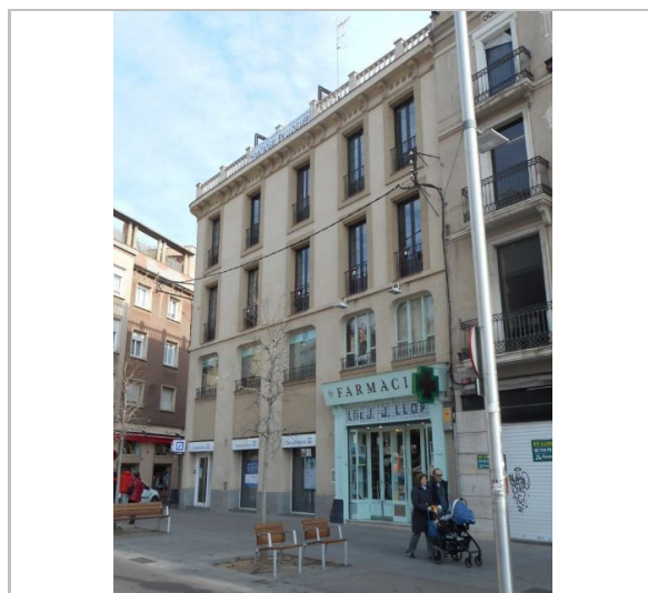
Fotografia de l'edifici (ER) Equip redactor
