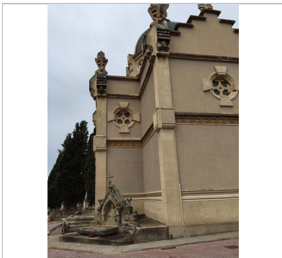
Façana posterior-lateral (ER) Equip redactor
