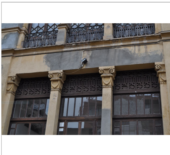
Detall fusteries i barana forja AV
