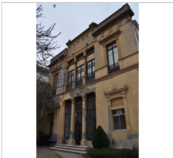
Fotografia del bé. Edifici 1888 (ER) Equip redactor
