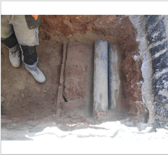
Galeria Subterrània AHS
