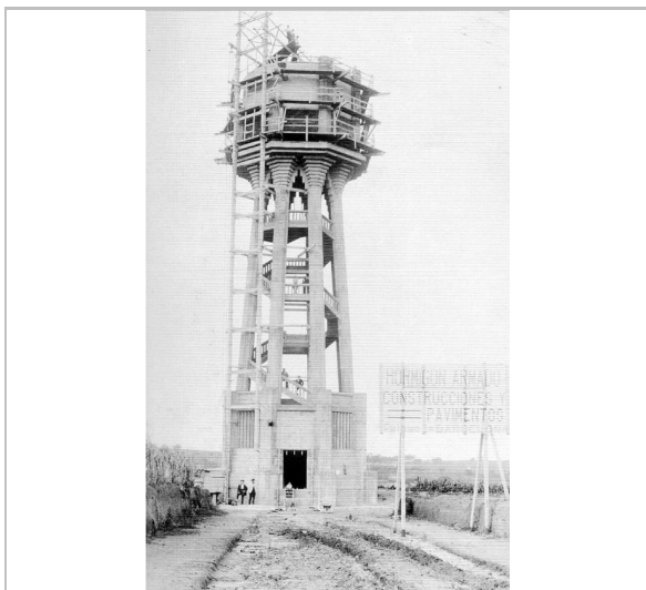
La Torre en construcció AHS - AJR
