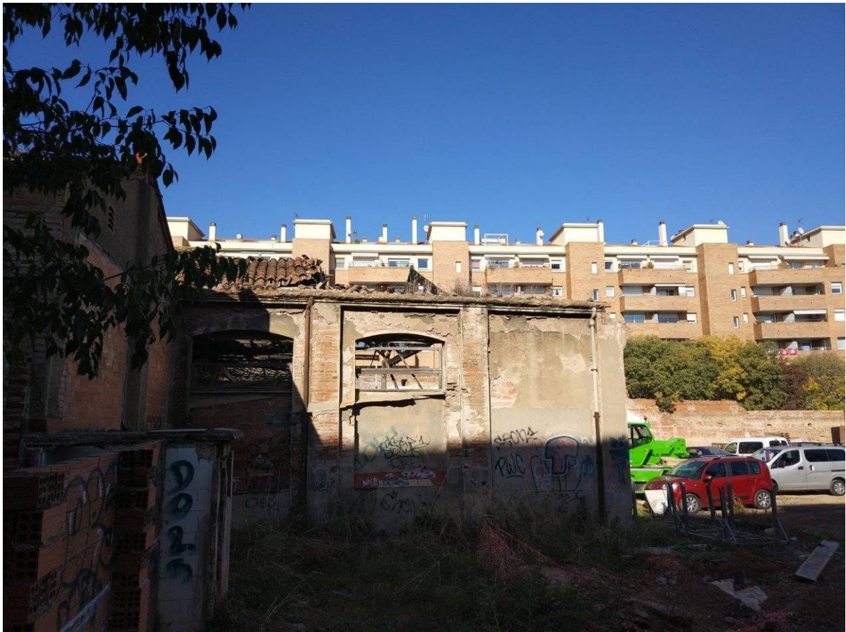
Vista de les tres crugies en ruïnes situades en l'espai interior d'illa, sobre la qualificació de reserva d'equipament local.
