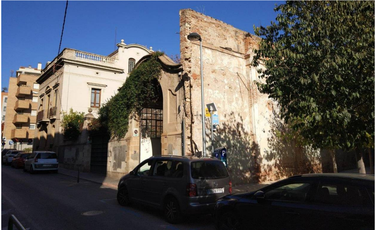
Conjunt de la casa Montllor i la nau adjacent, situada al número 15, antigament destinada a cotxeres. Visió de la paret mitgera que actualment dona front al nou espai lliure de comunicació amb l'espai interior d'illa
