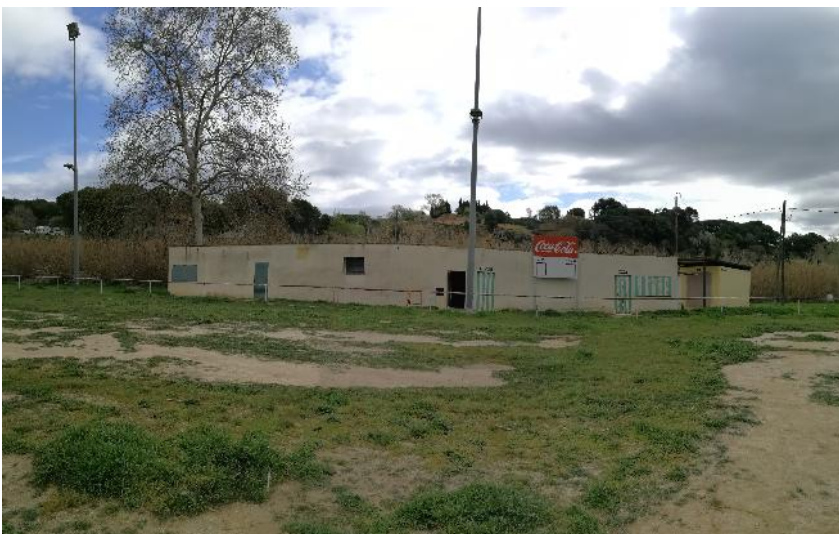
Edificacions annexes de vestuaris-bar i lavabos
