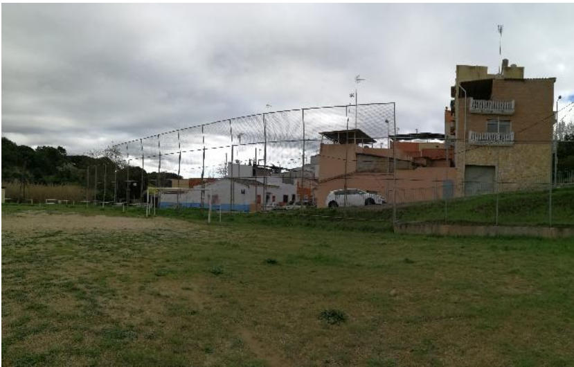
Porteria amb para-pilotes posterior
