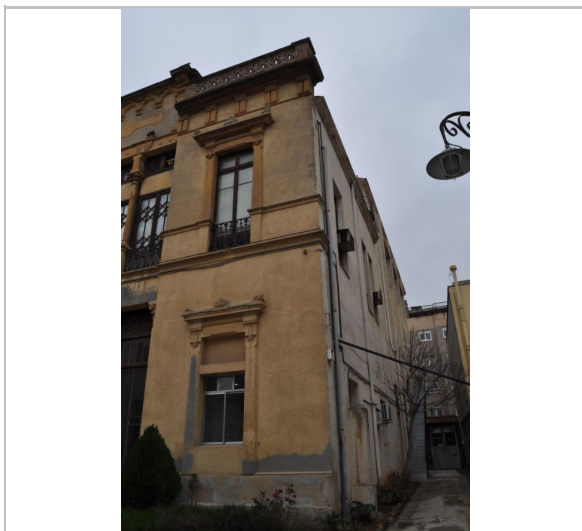
Façana lateral i pas exterior (ER) Equip redactor
