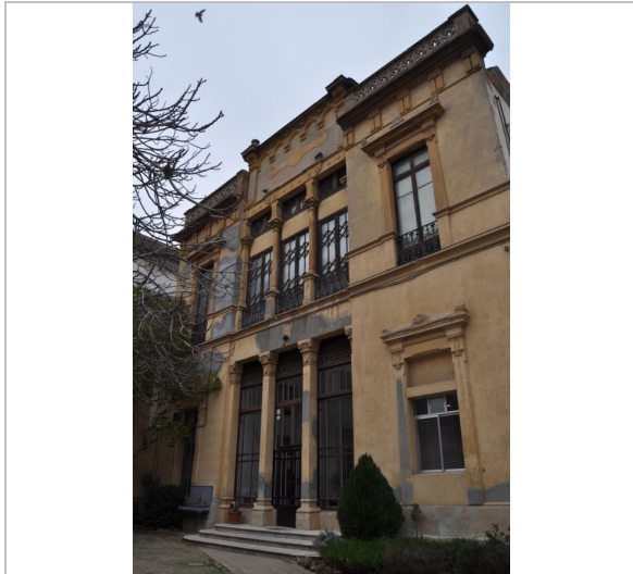
Fotografia del bé. Edifici 1888 (ER) Equip redactor
