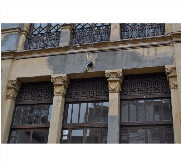
Detall fusteries i barana forja AV
