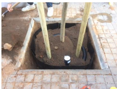
tub aireació interior escocell
