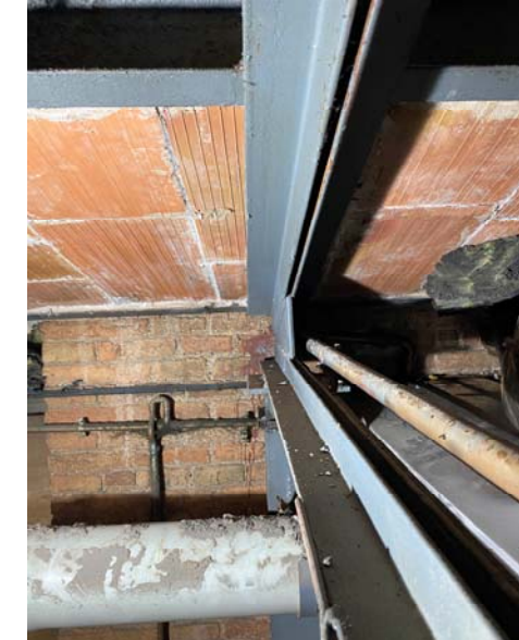
Imatges Cala 1-5 – Sostres Nau B – Espai sota coberta i formació de canal de recollida lateral
