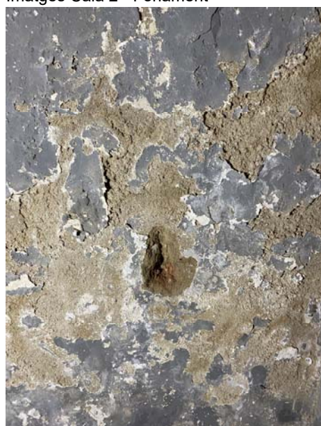
Imatges Cala 2 - Façana
