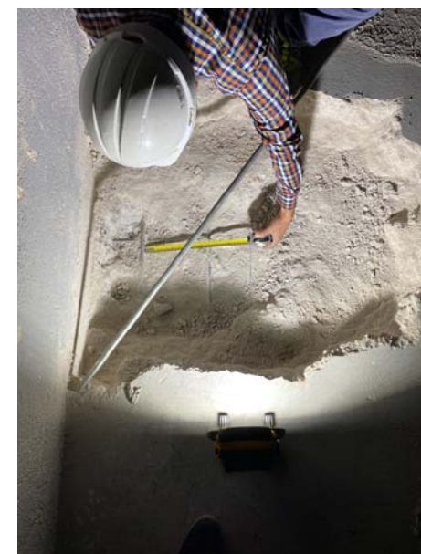
Imatges Cala 4 – Solera
