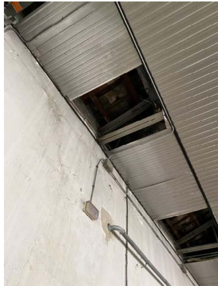
Imatges Cala 1-14 – Sostres Nau A – Jàsseres originals
