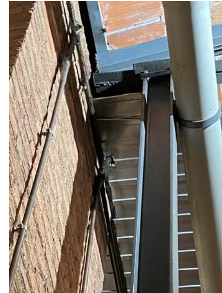
Imatges Cala 1-5 – Sostres Nau B – Suport jàsseres metàl·liques
