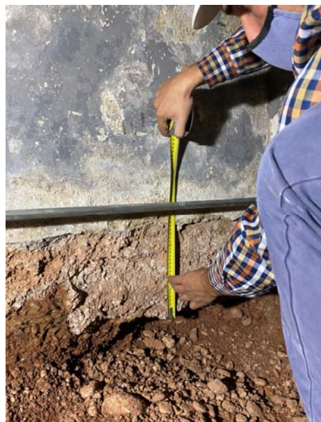
Imatges Cala 2 - Fonament
