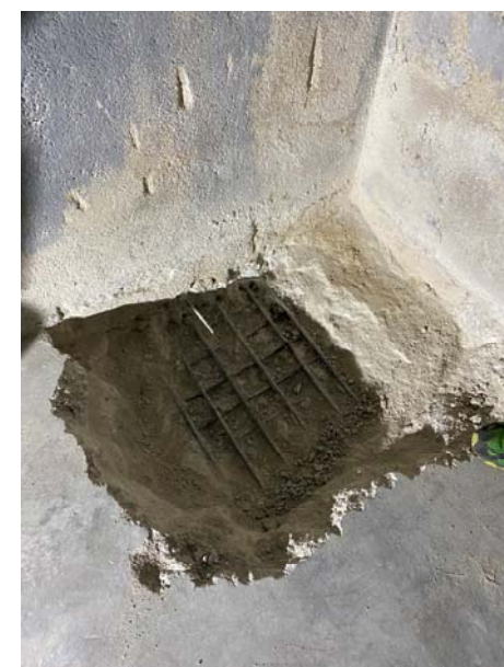
Imatges Cala 3 – Solera
