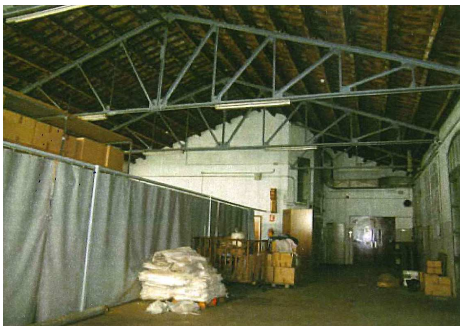
Nau 1a (front a carrer de Cellers)
