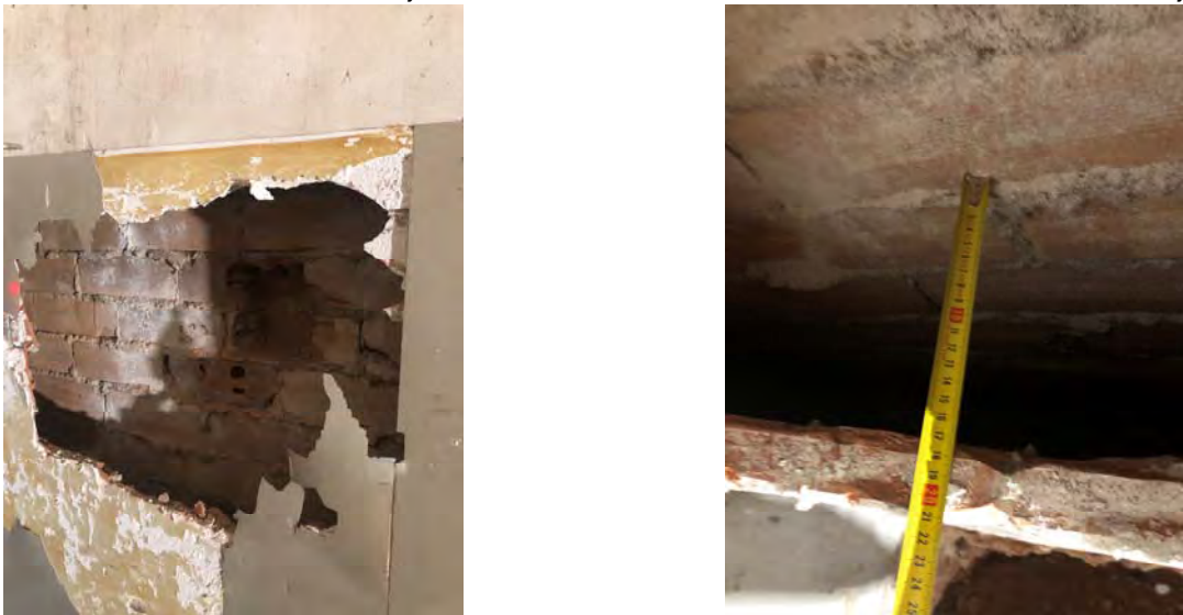
Imatges Cala B5 – Fonament en peu de mur en Soterrani Nau E i trasdossat
