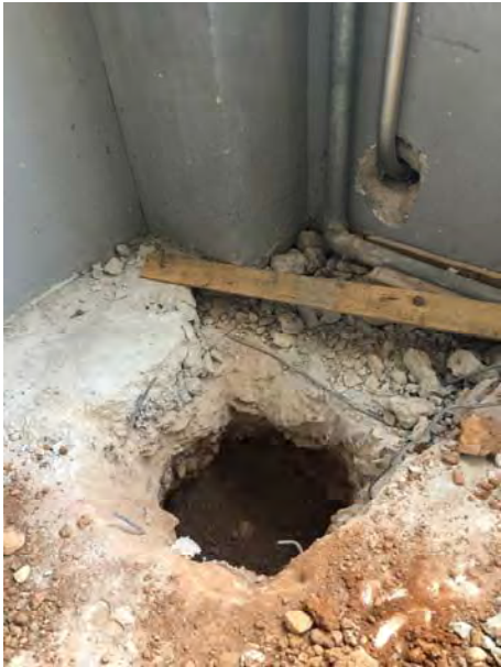
Imatges Cala 5 – Solera armada Nau G
