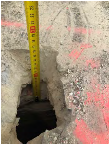
Imatges Cala 3 – Forjat sobreposat
