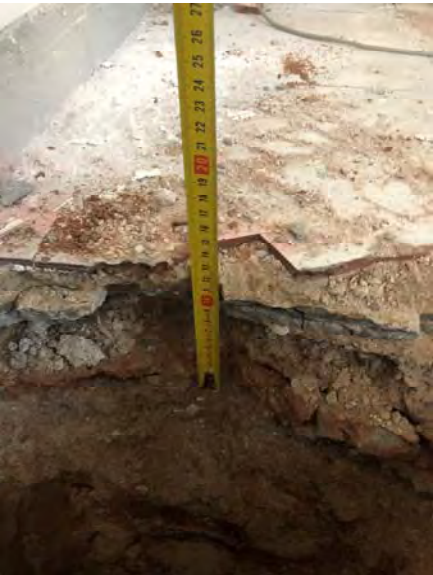
Imatges Cala A10a – Fonament en peu de façana i mur interior Nau J
