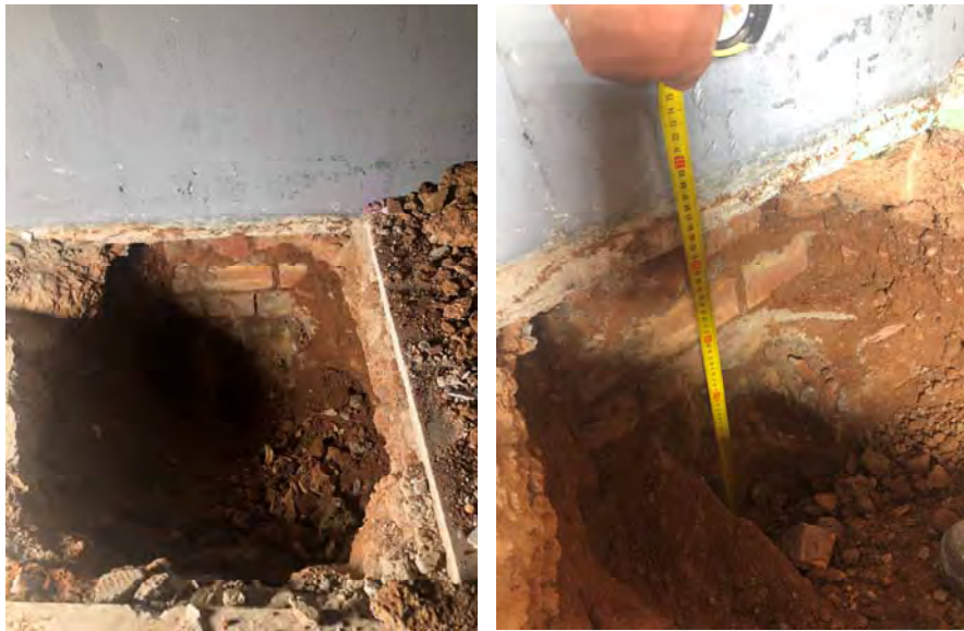
Imatges Cala B4c –Peu de mur de gero entre nau D i E
