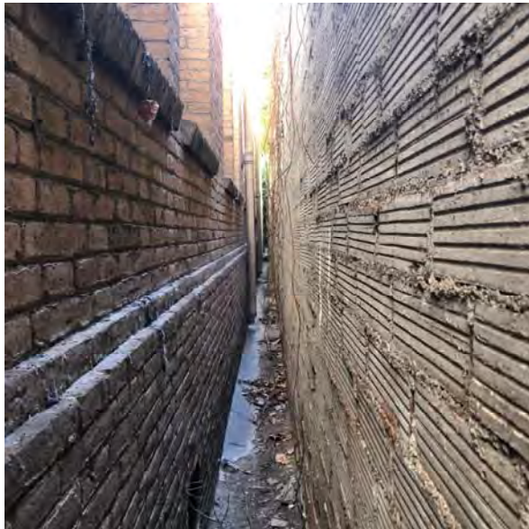
Imatges Cala 4 – Façana Sud Nau E
