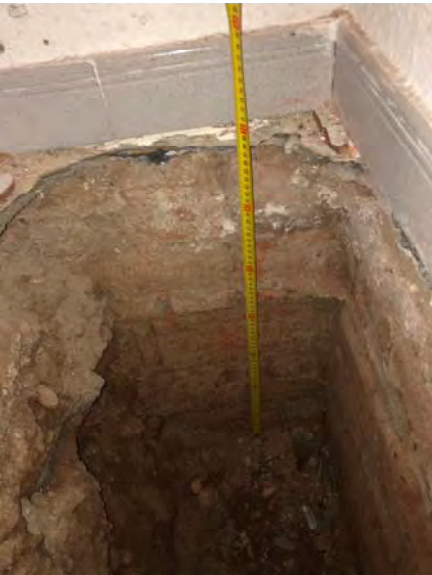
Imatges Cala A10a – Fonament en peu de façana i mur interior Nau J
