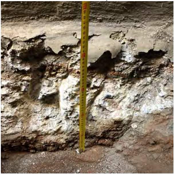
Imatges Cala 4 – Fonament mur de tancament
