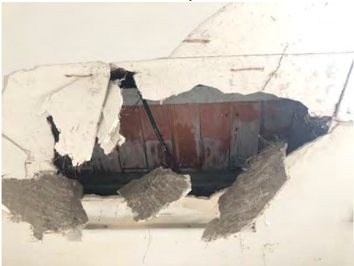
Imatges Cala C5 – Fals sostre nau L
