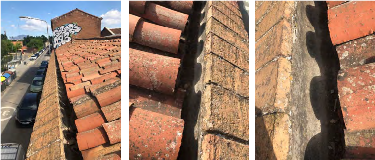
Imatges Cala C6b – Coberta Nau H.2
