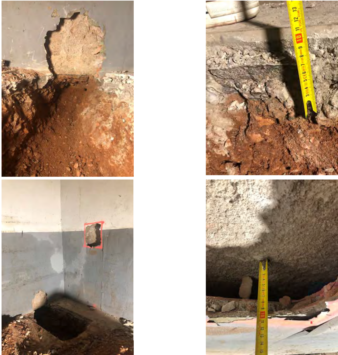
Imatges Cala B1 – Fonament en peu de mur en Soterrani Nau C i trasdossat
