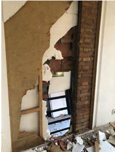
Imatges Cala A9 – Obertura en façana Est Nau H.2
