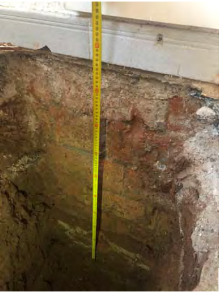
Imatges Cala A10b – Fonament en peu de façana Est Nau J
