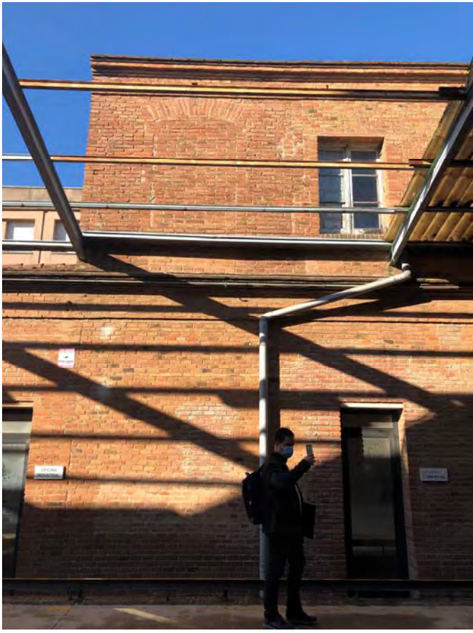
Façana Nau J interior del conjunt Sallarès Deu
