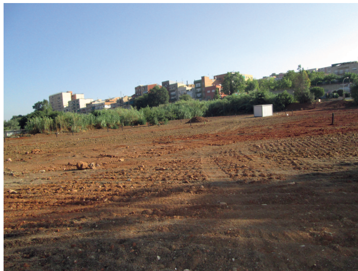
Després dels enderroc
