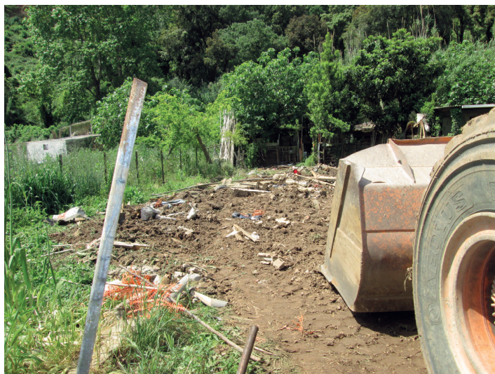
Imatges de la zona pendent d'ordenació
