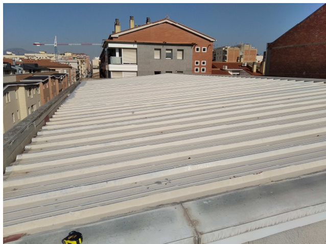
Estat de la canal de recollida d'aigües.
