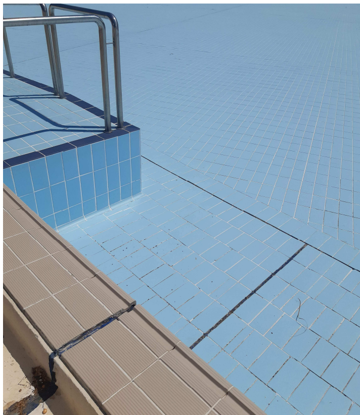
Detall de junta contínua en canal desbordant
