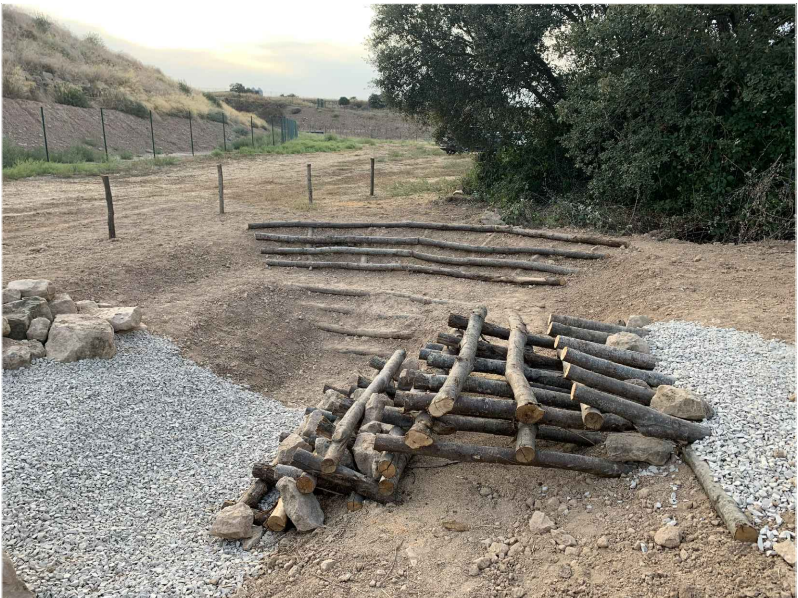
Exemple d'entramat per amfibis instal·lat en una bassa
