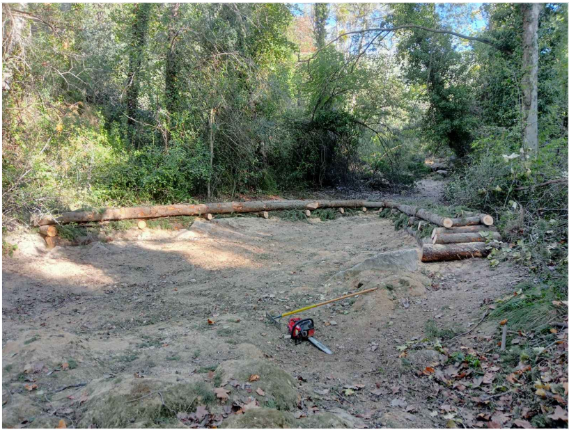
Exemple de Cross-Vane amb entramat doble
