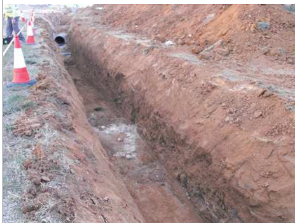
Excavacions Equip redactor
