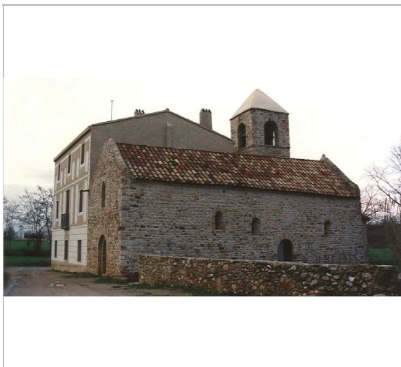
Fotografia del bé des del sud MHS
