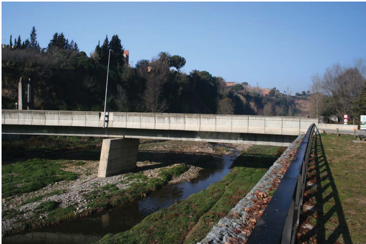
Pont d'accés des de Can Puiggener
