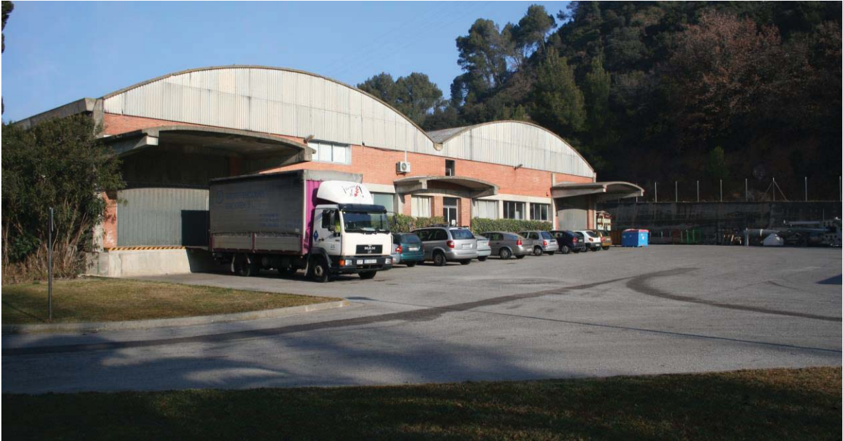
Façana principal nau actual
