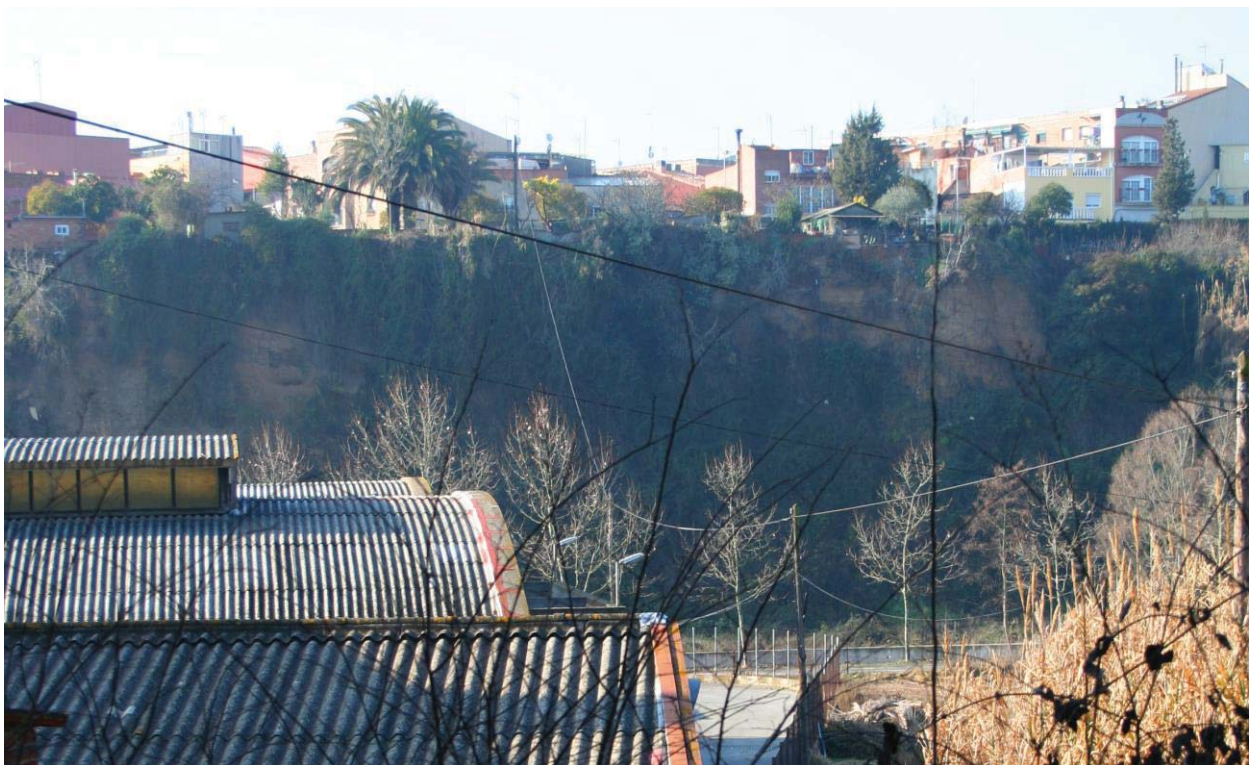
Marge dret del riu Ripoll on s'aprecia la diferència de nivell entre la coronació de la nau existent i les edificacions veïnes.
