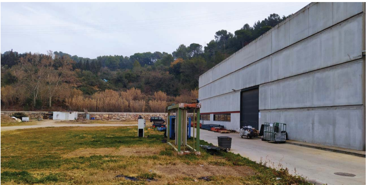
Façana NW de la nau ampliada el 2012
