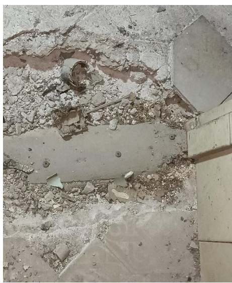
Cap de biga de fusta destapada per a tractament contra tèrmits
