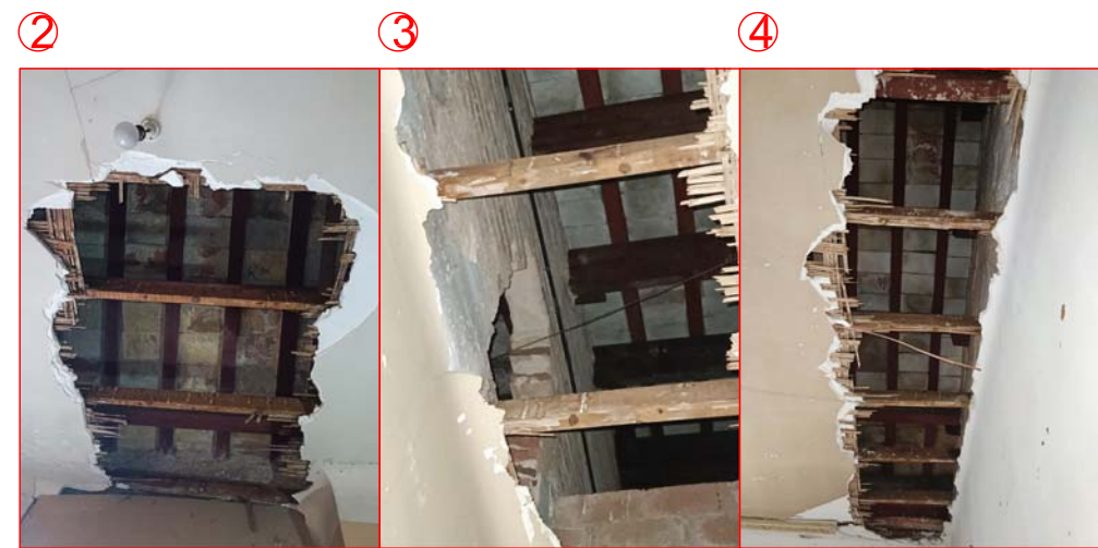
2 COBERTA INCLINADA BIGUES DE FUSTA RECTANGULARS SOBRE MURS DE CÀRREGA RASTRELLS, MAÓ MASÍS, TEULA
