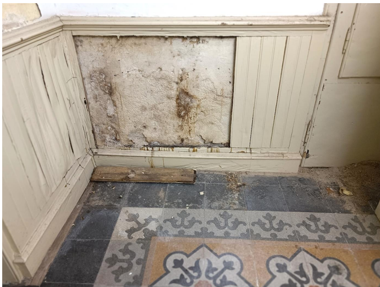
Arrimador de fusta en planta baixa, molt malmès
