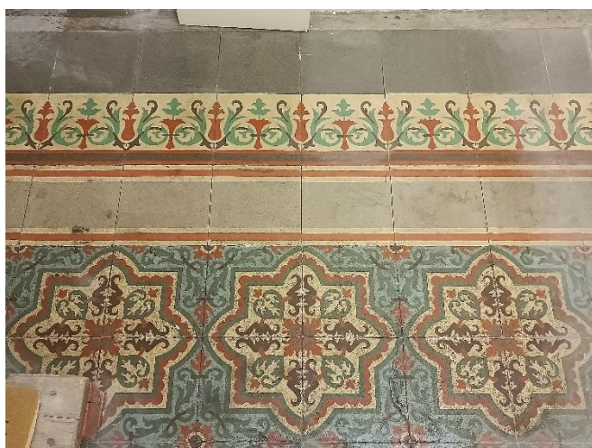
Paviment Hidràulic sala (3)
