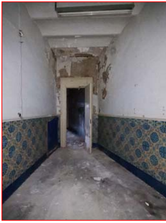
4 FORJAT BIGUES DE FERRO AMB VOLTA VISTA
