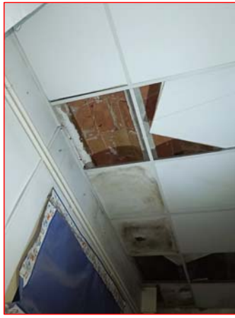
2 FORJAT BIGUES DE FORMIGÓ I FUSTA AMB VOLTA
