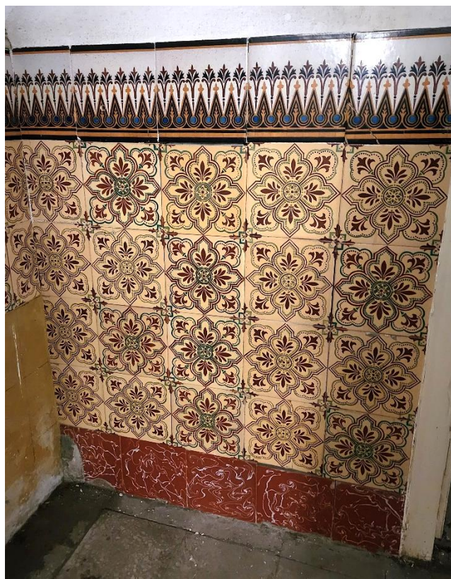
Arrimador al passadís a l'alçada dels lavabos PB
