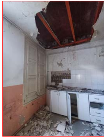
3 FORJAT BIGUES DE FERRO AMB VOLTA
