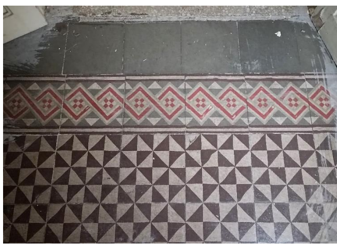
Paviment Hidràulic passadís (17)
