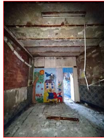
5 FORJAT BIGUES DE FERRO AMB VOLTA VISTA
