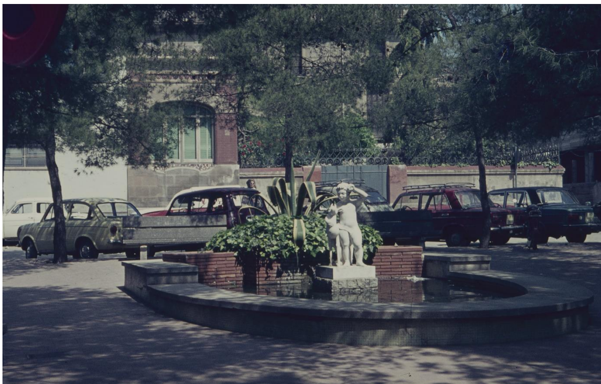
1970/1975 - Font ornamental a la plaça dels Màrtirs, actual plaça del Gas. Sabadell.
