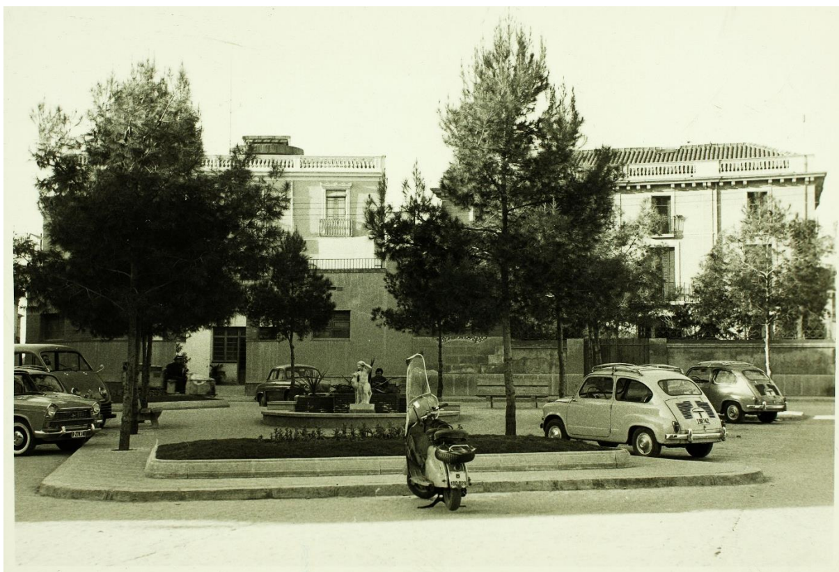
1958 - Vista general de la Plaça del Gas. Sabadell - Autor: desconegut/AHS.
