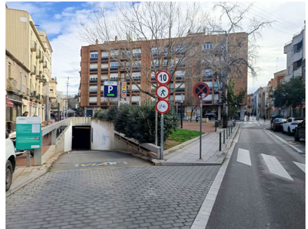
Pàrquing Mercat Central (entrada Sud)
