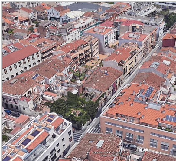
Panoràmica des de l'oest Google Earth
