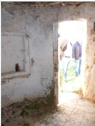
Interior. Paret est AHS
