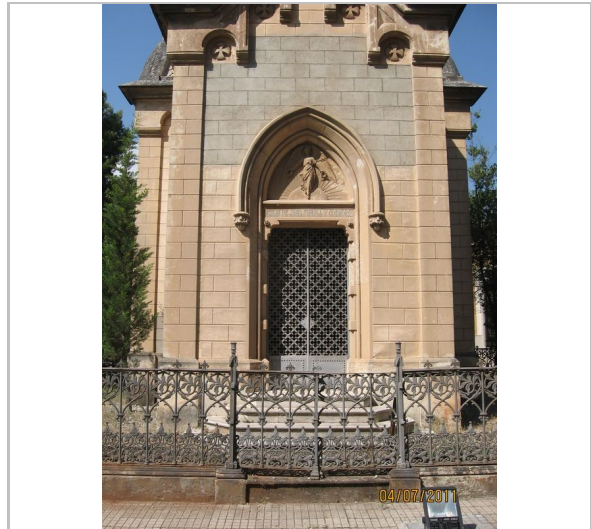
Façana principal AS-DB
