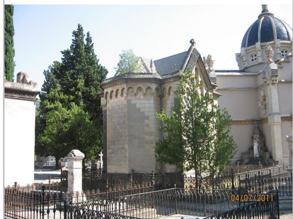
Façana lateral i posterior AS-DB
