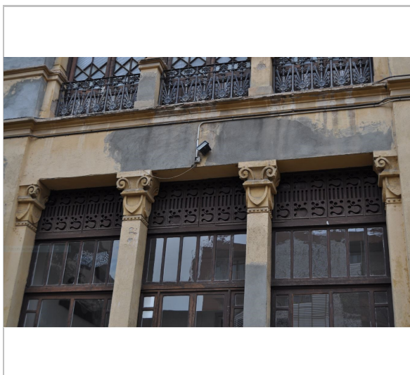
Detall fusteries i barana forja AV
