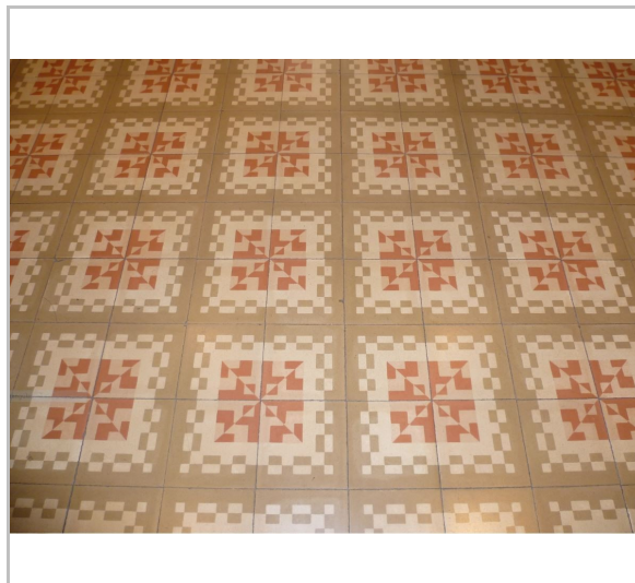
Paviment hidràulic G.Ribé AHS
