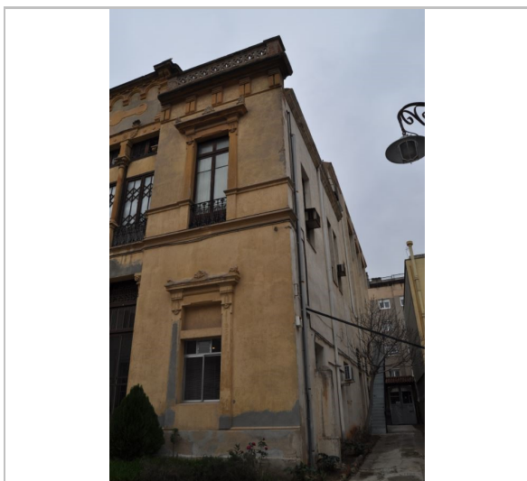
Façana lateral i pas exterior Equip redactor
