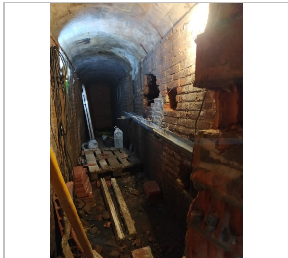
Galeria Subterrània AHS
