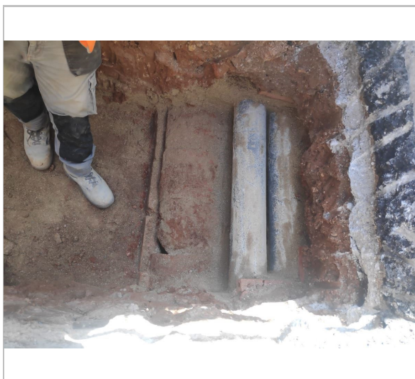
Galeria Subterrània AHS
