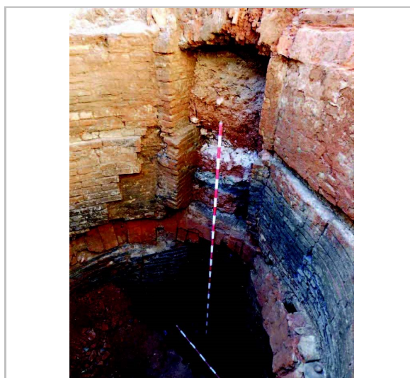
Vista interior forn de terrissa ARRAGO SL
