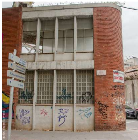
Fig. 22: Mòdul nord-est de finestres.
