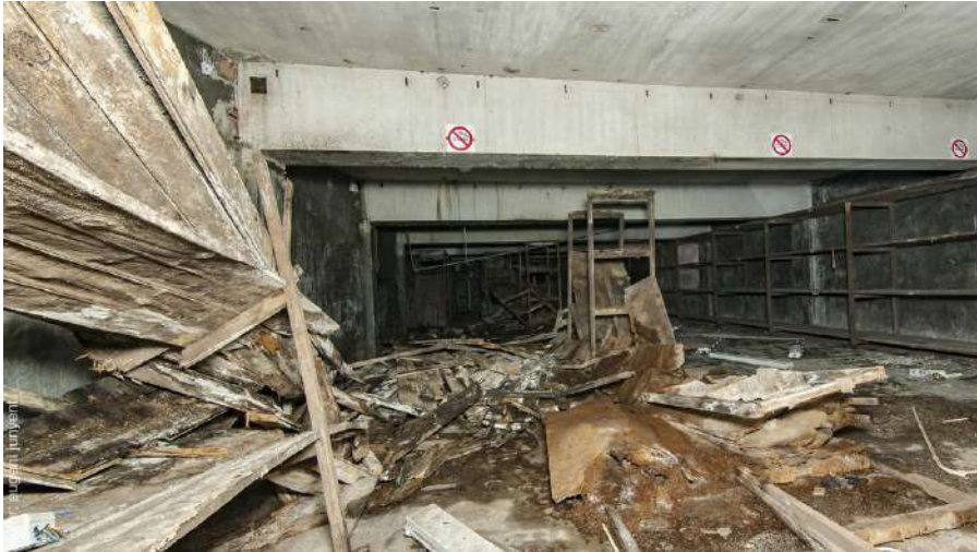
Fig. 40: Vista del magatzem nord de l'espai de soterrani.
