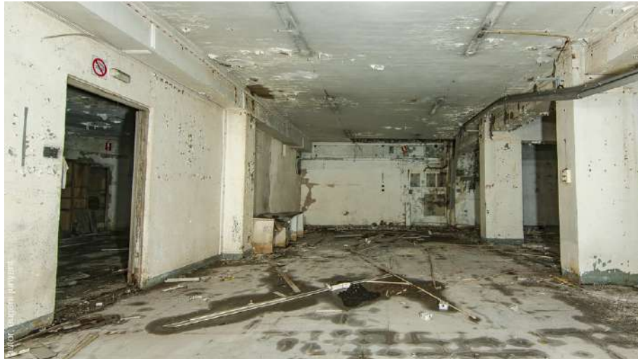
Fig. 42: Tram sud de l'espai central del soterrani. A l'esquerra la porta que comunica amb l'espai sud.
