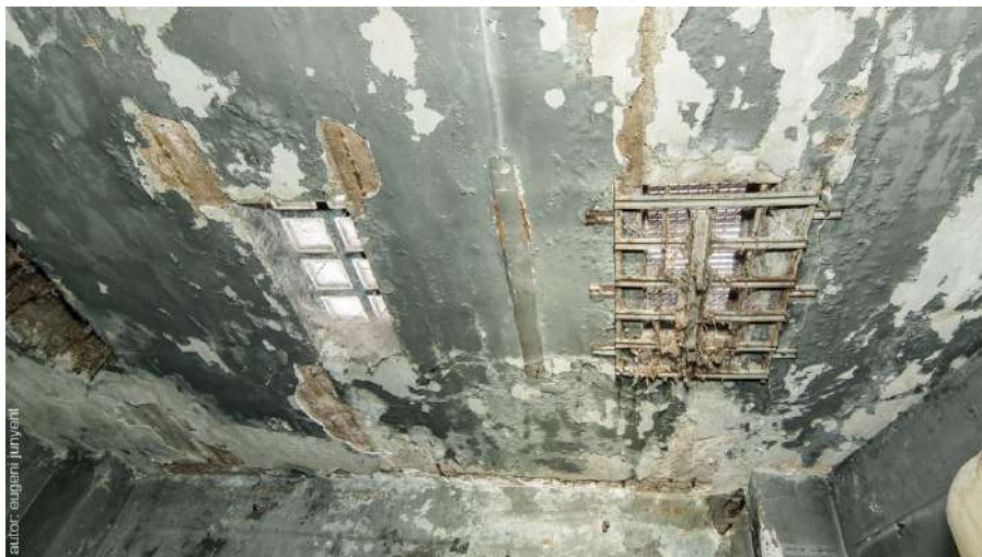
Fig. 45: Finestres zenitals a la sala de caldera, que menen sota el porxo de l'entrada.
