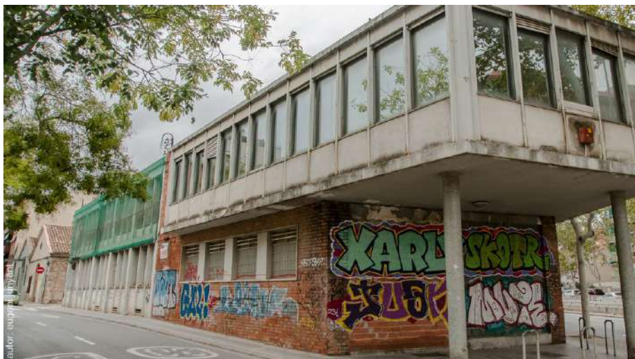
Fig. 24: Vista de la façana oest amb el xamfrà en primer terme. Al fons, a l'altra banda del carrer, podem veure la nau que va ser construïda també el 1891, juntament amb les dues naus de la primera fase constructiva de la finca.
