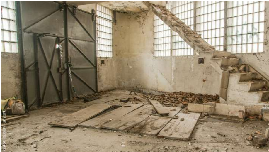
Fig. 34: Planta baixa. Porta d'entrada al nord i escales d'accés al primer pis. Sota d'aquestes tenim les escales de baixada al soterrani. Tapat amb fusta tenim una obertura que hauria comunicat els dos espais.
