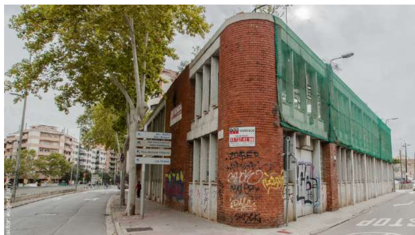
Fig. 20: Vista de la façana nord i est a la cantonada entre Fèlix Amat i Marqués de Comillas. A la dreta de la cantonada tenim l'entrada posterior al recinte, directament a magatzem.
