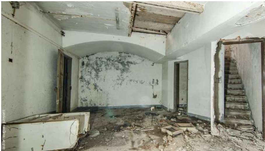
Fig. 39: Espai distribuïdor al final de les escales.
