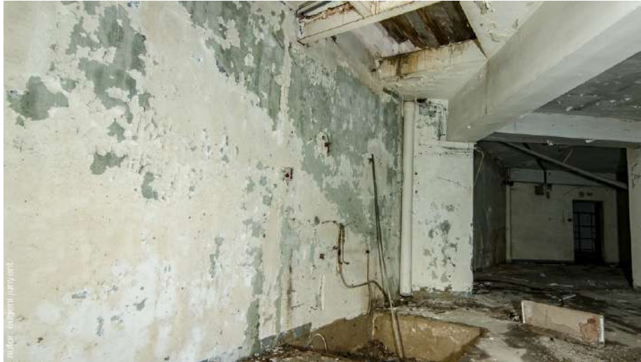
Fig. 46: Obertura al sostre de l'espai de soterrani, que hauria comunicat amb el primer pis.
