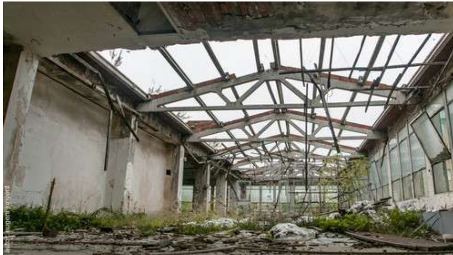
Fig. 36: Planta pis. Vista general de la nau nord.
