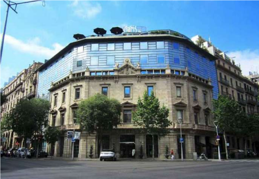
Palau Vedruna Barcelona MBM Arquitectes
