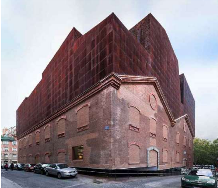
Edifici CaixaForum. Madrid Herzog & de Meuron
