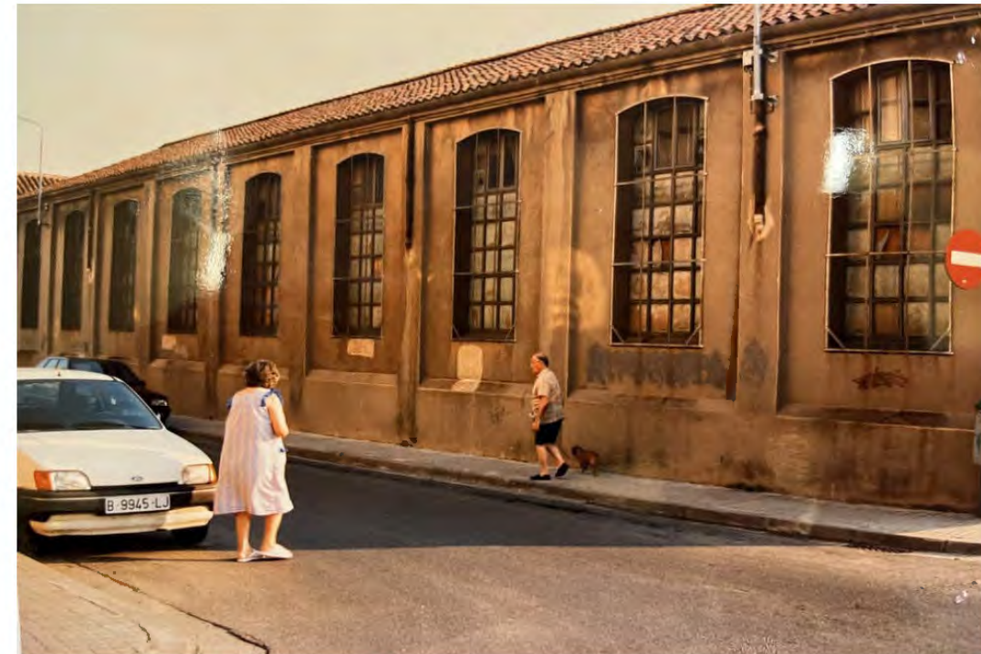
1996. En aquest any es sol·licita llicència municipal per al "Projecte de neteja de les naus, retirada de deixalles i utilatge existent a l'interior; obres de reparació i conservació; repàs de goteres de la coberta; repassos d'arrebossats de les façanes interiors al pati i paviment del mateix", redactat per el "Projecte d'obres per obrir una porta d'accés de vehicles a la façana principal", per encàrrec de l'empresa Xarol, S.A. a través de l'administrador José Joaquín Roperó Giménez . Autor: Desconegut
