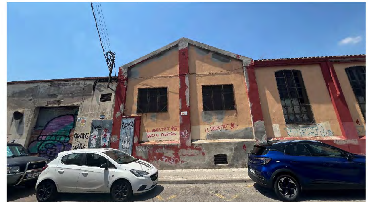
2025. Visió de la façana testera de la nau transversal que tanca la "U" que conforma el conjunt de les tres naus que articulen la disposició projectada per Josep Renom, l'any 1919. La façana segueix el mateix llenguatge compositiu i formal que en la resta de les façanes testeres i determinant el final de la façana longitudinal al carrer de la Reina Elionor. Autor: Antoni Vilanova (V+M)
