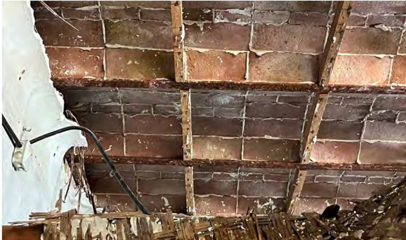
2024. Sostre de la planta primera d'oficines. (V+M)
