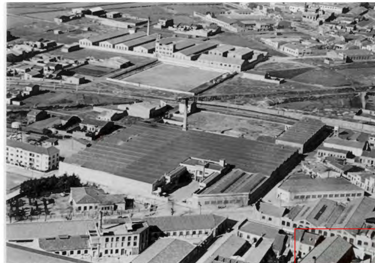
1945. Imatge aèria de la nova planta de la fàbrica Marcet, seguint l'estil del racionalisme de postguerra. Al fons de la imatge es veuen les fàbriques Baygual i Llonch, en el seu front amb el carrer de Jacquard. Per sota apareix el traçat de l'elèctric, més avall la nova fàbrica Marcet, amb la Guarderia ja construïda. Per davant de l'accés principal se situa el carrer de Pau Claris i seguint la imatge a la dreta, trobem novament la imatge de la segona nau de Juli Puncernau (emmarcada en vermell ), una part del pati del recinte i la porta d'accés al mateix.
