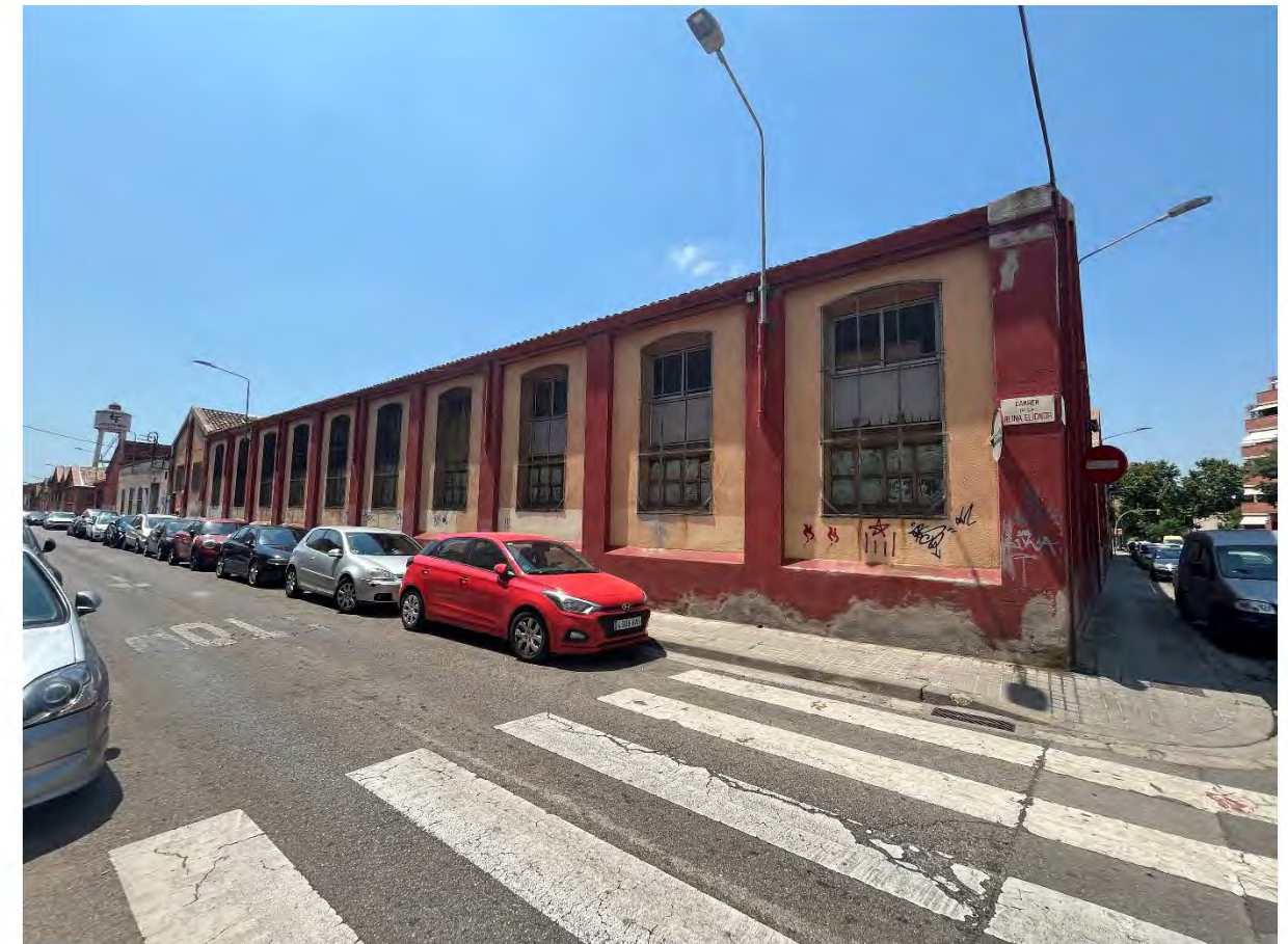
2025. Visió de la nau que conforma la cantonada entre els carrers de Pau Claris (façana testera) i de la Reina Elionor (façana longitudinal). Al fons de la imatge el dipòsit de l'aigua de la fàbrica Sallarès i Deu. Autor: Antoni Vilanova (V+M)
