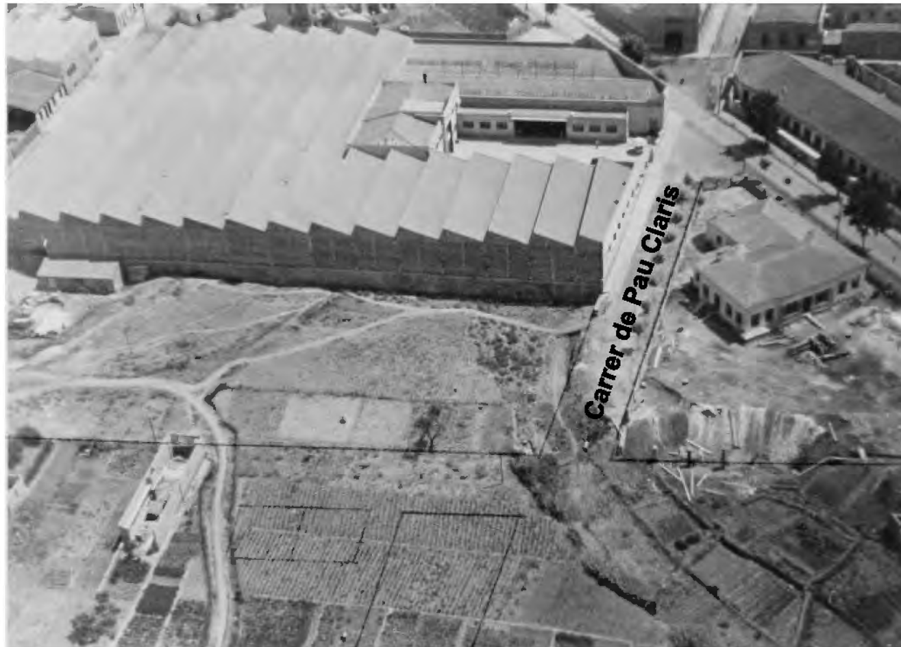
1944. Imatge aèria de la construcció de la nova planta de la fàbrica Marcet (al nord de la carretera de Molins de Rei que apareix esbiaixada a l'extrem esquerre de la imatge) i entorn. A la dreta, la que hauria de ser la Guarderia, encara en construcció.
