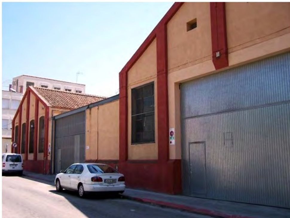
2006. Antiques instal·lacions del vapor Marcet. Naus de Juli Puncernau amb front al carrer de Pau Claris. La imatge ens permet constatar i les alteracions realitzades sobre les dues naus principals del conjunt de Juli Puncernau . Així, mentre la nau de la dreta que conforma la cantonada amb el carrer de la Reina Elionor, es troba perfectament composta i amb les obertures característiques, la de l'esquerra ha patit una modificació molt substancial, especialment en l'obertura del gran forat central per encabir-hi l'accés de diferents vehicles. Aquest aspecte ha desfigurat la composició simètrica original, amb l'altre edificació, alhora que ha modificat els finestrals constituents del projecte de Josep Renom. Autors: Eugeni Junyent / Maria Carme Carmona
