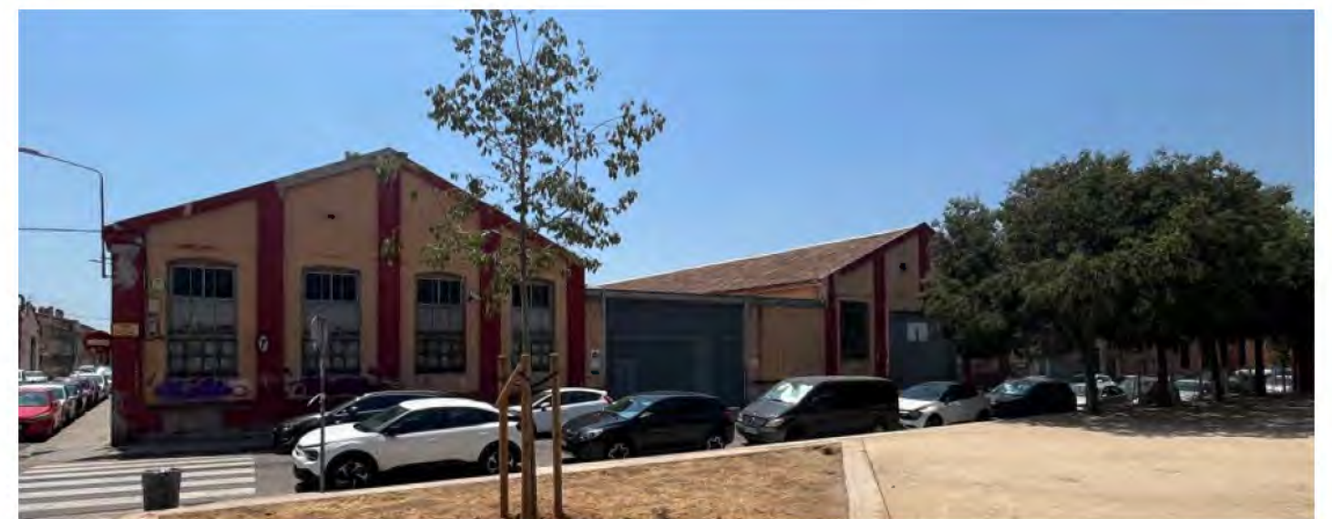
2025. Visió frontal del conjunt de les dues naus longitudinals de Juli Puncernau encarades al carrer de Pau Claris. L'enderroc de les naus Marçet que ocupaven l'illa delimitada per la carretera de Molins de Rei i els carrers de la Reina Elionor i de Pau Claris, ha possibilitat obrir noves perspectives visuals al davant del front que ofereixen les dues testeres de les naus, significat un guany important per a una millor visualització del conjunt preservat.
