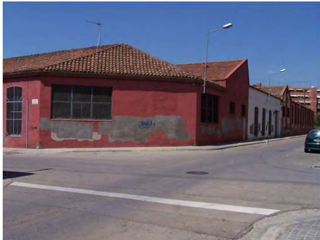
2006. Visió de la nau industrial projectada el 1902 pel Mestre d'Obres Francesc Renom, pare de l'arquitecte. Presa de la imatge des del xamfrà entre el carrer de la Reina Elionor i el carrer de Cellers. Autors: Eugeni Junyent / Maria Carme Carmona
