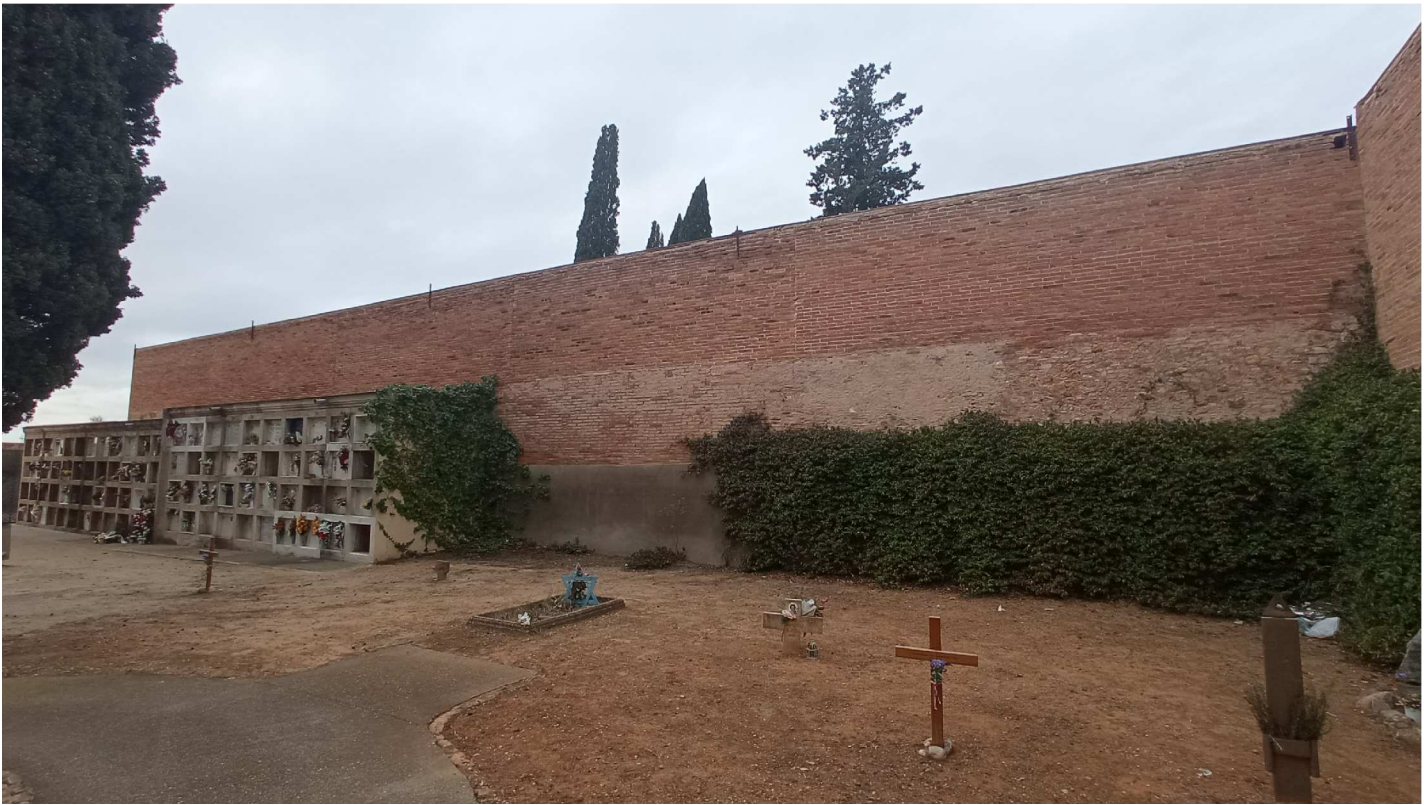
FAÇANA EST SECTOR XALOC (ZONA CEMENTIRI DELS DISIDENTS)
