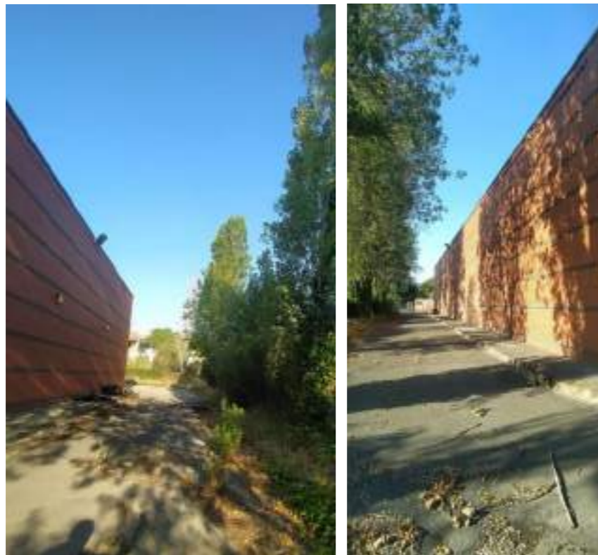
Figura 4. Zona lateral de l'edifici de l'EBAR Sant Oleguer
