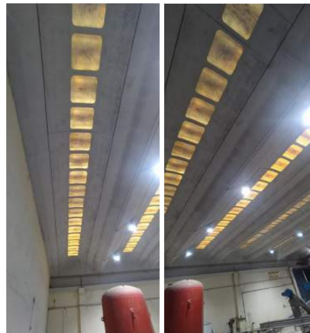
Figura 2. Interior de la teulada, recoberta amb diferents punts de translucidesa.
