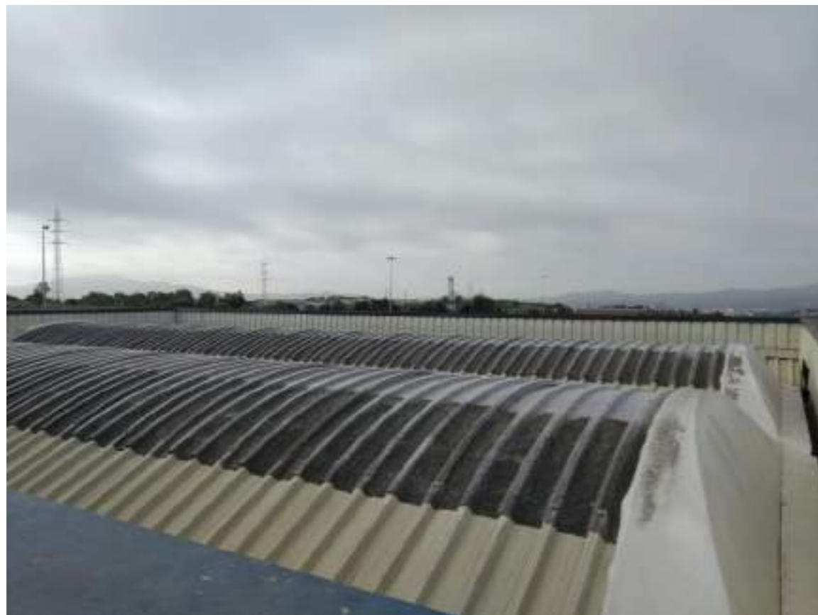
Figura 1. Tipologia de la teulada de l'edifici de l'EBAR Sant Oleguer. Foto de l'EDAR Riu Ripoll
