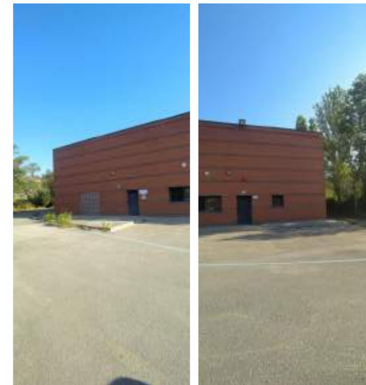
Figura 6. Zona d'accés a l'EBAR Sant Oleguer
