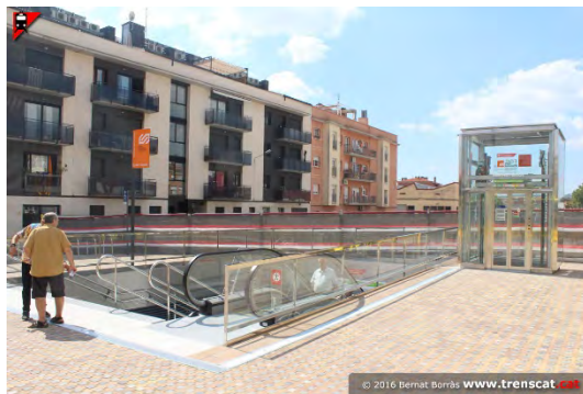
Taula 8. Estació de FGC línia S2
