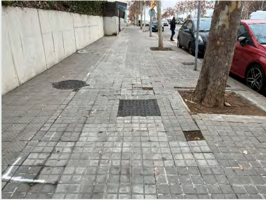
Vorera sud de la ctra de Terrassa, amplada accessible però paviment irregular.
