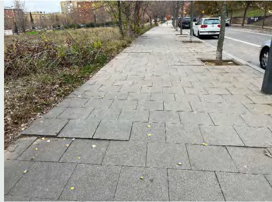
Voreres amb trams amb paviment aixecat, c. Kurdistan.
