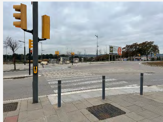
Pas de vianants accessible amb paviment podotàctil, Ronda Jean Monnet
