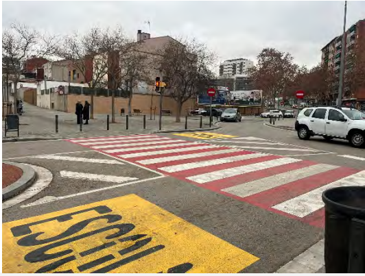
Pas de vianants ctra. Terrassa – c. de Malta, pas de vianants accessible zona escolar
