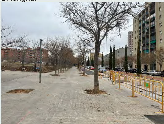
C. de Malta, vorera accessible en obres.
