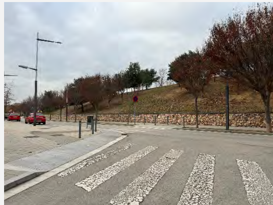
Passos de vianants accessibles amb pintura desgastada, c. Kurdistan
