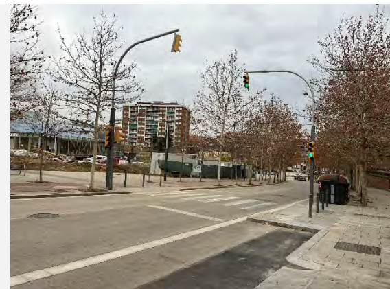
Carrer d'Hongria amb pas de vianants amb regulació semafòrica.
