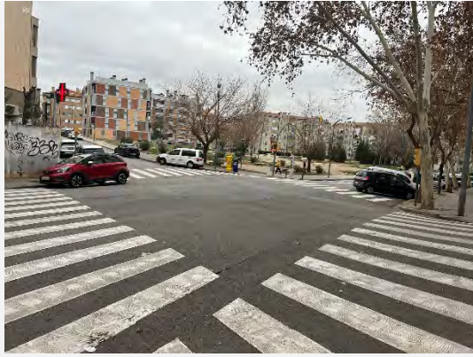
Cruïlla amb dotació completa dels passos de vianants, c. de la Palma – c. de Tenerife
