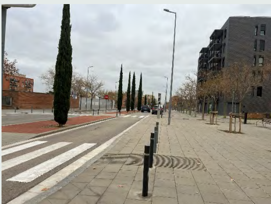
C. de Malta, vorera amb amplada accessible.
