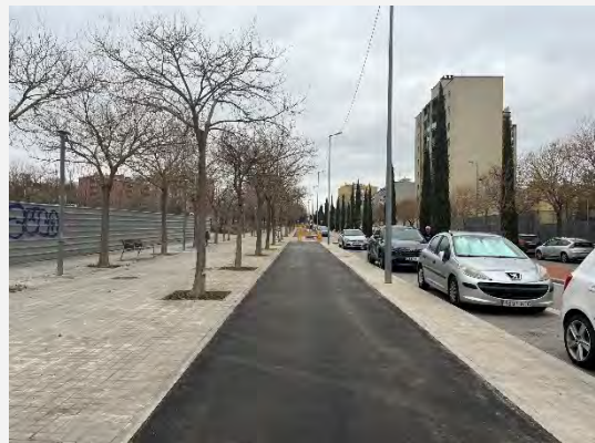
Obres al carril bicicleta, c. de Malta
