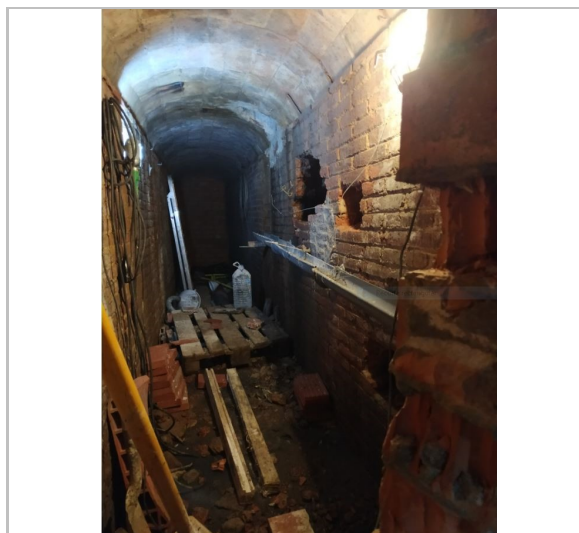
Galeria Subterrània AHS
